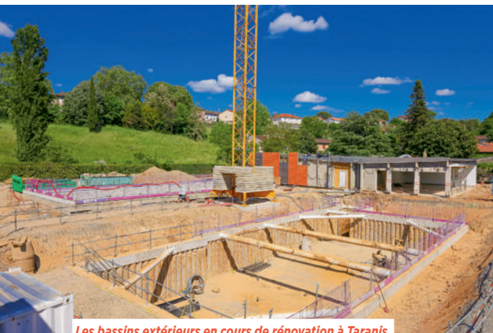
Les bassins extérieurs en cours de rénovation à Taranis
