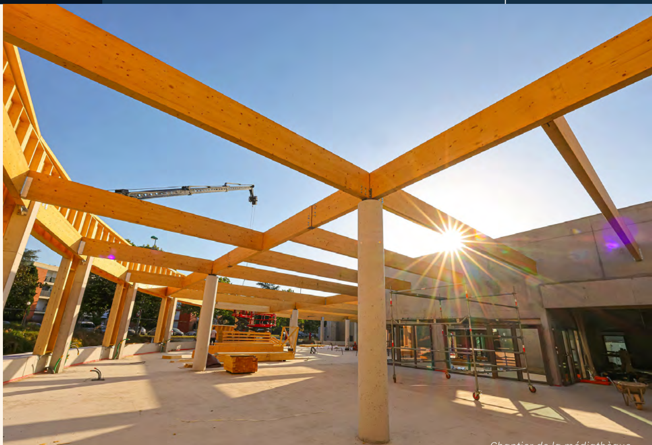
Chantier de la médiathèque de Cantepau à Albi
