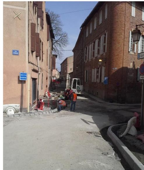
Dans le même temps, les travaux sur les réseaux se poursuivent dans la rue de la Madeleine entre la rue Rinaldi et la rue de Metz jusqu'à la fin avril. Le remplacement d'un câble ERDF, la réhabilitation des canalisations assainissement et eau potable et la pose de fourreaux pour l'éclairage public sont concernés. La réfection des trottoirs et de la voirie interviendra ensuite à partir de fin avril en coordination avec la rénovation des abords et du parvis de l'église de la Madeleine.
